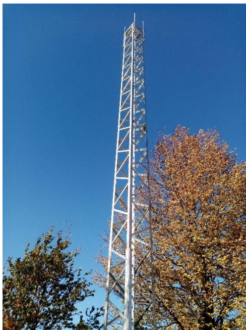
Ende September wurden die Antennen auf dem Ammelbrucher „Funkmast“ vom bisherigen Telekommunikationsanbieter entfernt. Bild: privat
